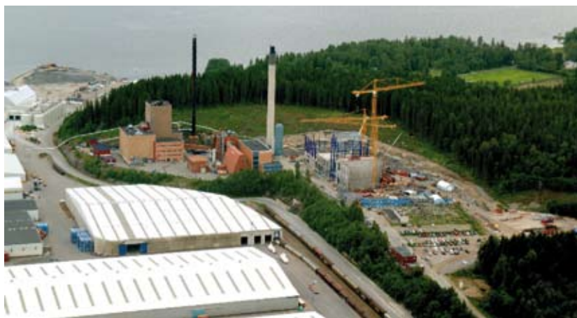
Foto: Sundsvall Energi AB
